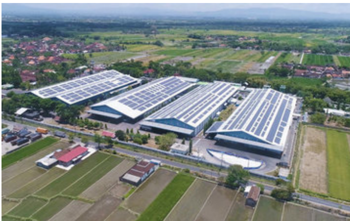
ダノン・アクアが屋根置き型太陽光発電設備を設置した中ジャワ州のクラテン工場（同社提供）
